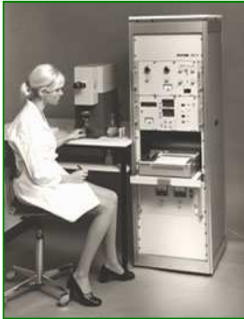
1968/69: ICP 11 Premier cytomètre commercialisé dans le monde. Développé par Prof. Goehde, distribué par Phywe.
